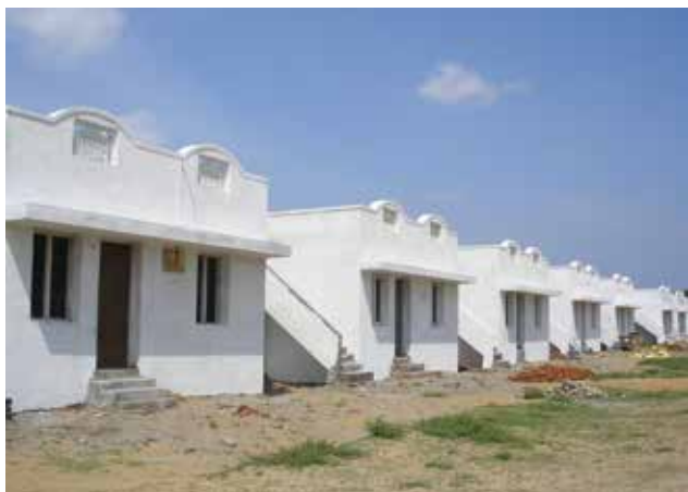
Die fertigen Wohnhäuser in Seruthur
